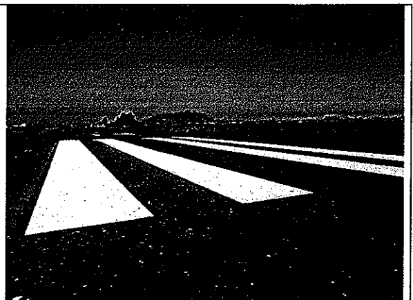
Foto N4. Pintura reparada Cabezal Norte pista Aer3dromo Curic3.
