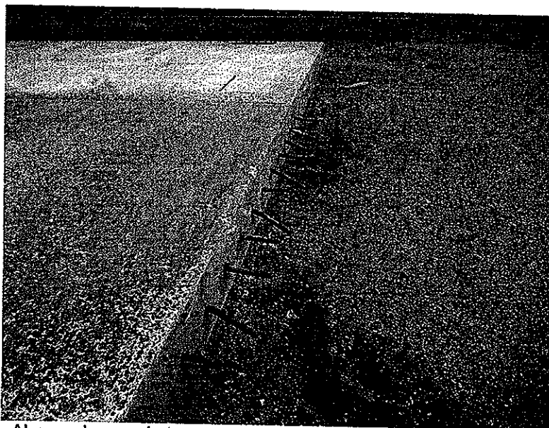
Algunas barras de traspase no están perfectamente horizontales
