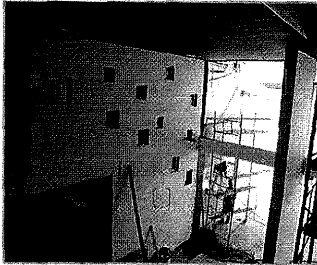
Fotografía N° 10: Ventanas faltantes en muro proyectado
