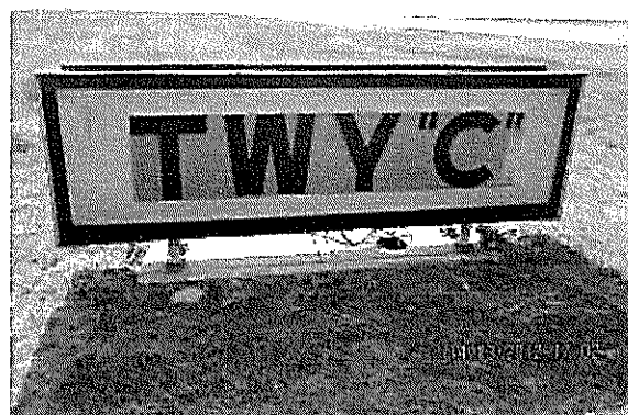
Fotografías N os 7 y 8 de 14/03/2012: Letrero de información de calle de rodaje B y C con color blanco sobre fondo amarillo fuera de norma.
