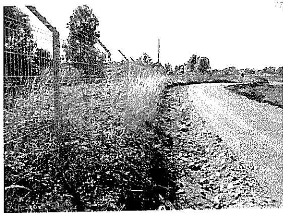
Fotografía N°57 de 08/03/2012: Aeródromo Cañal Bajo. Falta de mantención de cerco perimetral tipo OACI.
