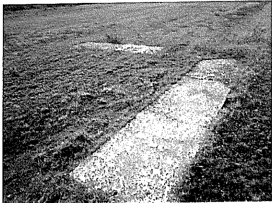
Fotografías N os 37 y 38 de 05/03/2012: Aeródromo de Pupelde. Balizas erosionadas.
