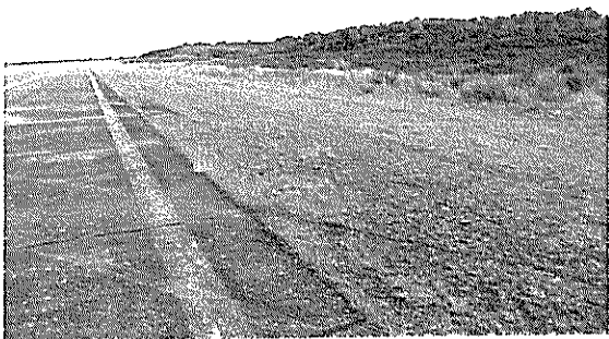
Fotografías N°s 17 y 18 de 05/03/2012: Aeródromo de Pupelde. Falta de uniformidad y cubrimiento de pintura en borde y eje de pista.
