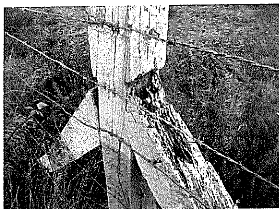
Fotografía N o 21 de 05/03/2012: Aeródromo de Pupelde. Falta de mantención de pintura y deterioro de postes de cercos en sector de umbrales.
