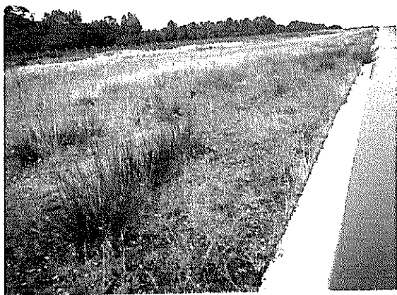
Fotografía N o 41 de 06/03/2012: Aeródromo de Quellón. Falta de mantención de roce en la franja de seguridad de la pista.
