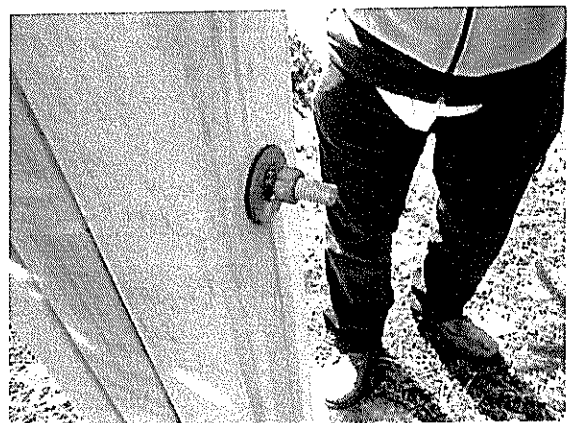
Fotografías N os 1 y 2 de 05/03/2012: Aeródromo de Pupelde. Costado oriente. Presencia de óxido en pernos de sujeción, rodamiento, canastillo metálico y mástil. Falta de mantención de pintura en mástil metálico bicolor.
