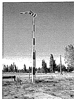
Fotografía N°132 de 28/03/2012: Aeródromo Los Confines de Angol. Indicador del viento no se ajusta a lo indicado en circular DAC 14 00 004 D.
