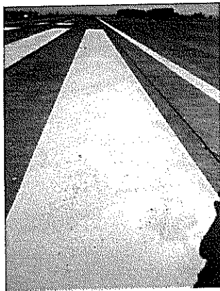
Fotografías N os 41 y 42 de 27/03/2012: Aeródromo de Victoria. Falta de uniformidad en la aplicación de pintura de las fajas de los umbrales de pista y borrado en desuso defectuoso de umbral 19.
