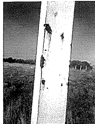
Fotografías N os 11 y 12 de 07/03/2012: Aeródromo de Tolquien. Costado poniente. Pernos de mástil oxidados y sueltos. Mástil con presencia de óxido.
