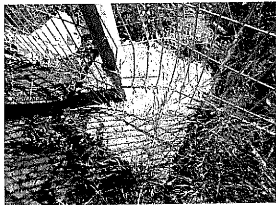
Fotografía N°58 de 08/03/2012: Aeródromo Cañal Bajo. Cerco perimetral tipo OACI doblado.
