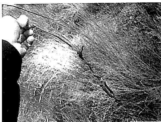
Fotografías N os 3 y 4 de 06/03/2012: Aeródromo de Quellón. Costado oriente. Cataviento desplomado y con presencia de óxido y falta de tensión en sus piolas.
