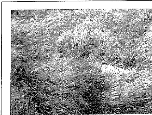
Fotografía N°13 de 15/03/2012: Aeródromo La Junta. Presencia de abundante maleza en la franja y pista alrededor de las balizas de señalización.
