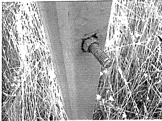
Fotografías N os 7 y 8 de 06/03/2012: Aeródromo de Quellón. Costado poniente. Pernos de sujeción y piolas con óxido.
