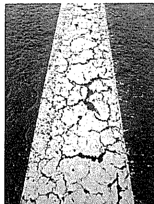
Fotografías N os 19 y 20 de 06/03/2012: Aeródromo de Quellón. Descascaramiento de pintura en señal designadora de espera de acceso a pista.
