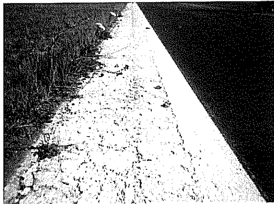
Fotografías N°86 de 29/03/2012: Aeródromo Villa Portales. Falta de cubrimiento y uniformidad en señales de borde de pista.
