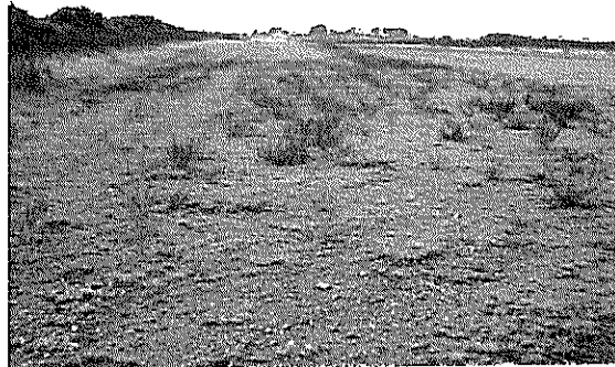
Fotografías N os 39 y 40 de 05/03/2012: Aeródromo de Pupelde. Pista de ripio con vegetación. En algunos sectores vegetación con altura de 60 cm.
