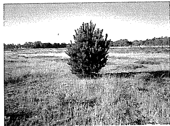
Fotografía N°54 de 08/03/2012: Aeródromo Cañal Bajo. Presencia de arbustos en sector de franja de seguridad.
