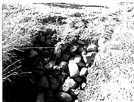
Fotografía N°114 de 28/03/2012: Aeródromo de Traiguén. Pozo absorbente para infiltrar el agua lluvia.
