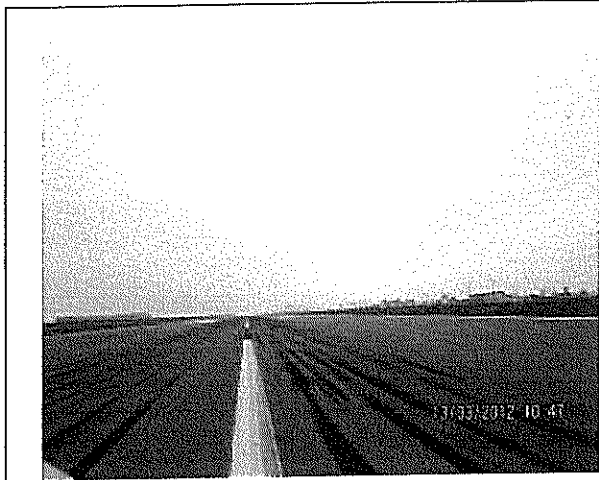
Fotografía N°13 de 13/03/2012: Presencia de caucho en la pista.
