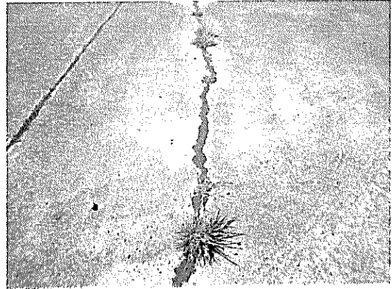
Fotografías N os 37 y 38 de 27/03/2012: Aeródromo de Victoria. Presencia de vegetación en los sellos de la plataforma de estacionamientos.
