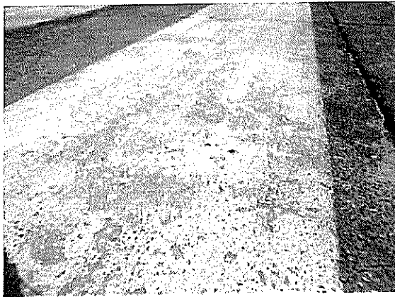
Fotografías N°s 15 y 16 de 05/03/2012: Aeródromo de Pupelde. Falta de uniformidad y cubrimiento de pintura en umbrales de pista.
