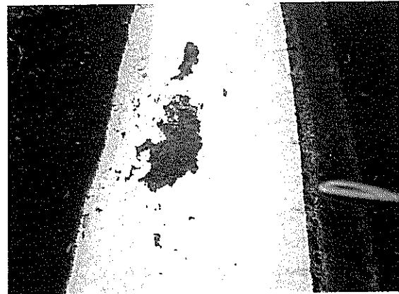
Fotografía N°76: Aeródromo Los Confines de Angol de 28/03/2012. Descascaramiento de pintura en señal de eje de curva de calle de rodaje.
