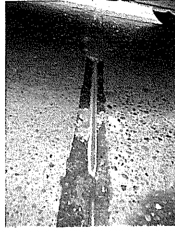
Fotografías N°s 1 y 2 de 26/03/2012: Maquehue. Falta de instalación de luces piloto, automáticos, cajas de derivación y falta de sello de junta de pavimento en sector de estacionamientos.
