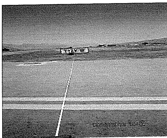
Fotografías N os 9 y 10 de 19/03/2012: Letrero de información ubicado a distancia insuficiente de eje de calle de rodaje.
