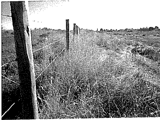
Fotografía N°27 de 27/03/2012: Victoria. Falta retiro de arbustos y basura a 2 metros de cada lado del eje del cerco agrícola.
