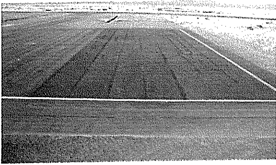
Fotografías N°s 15 y 16 de 28/02/2012: Aeródromo Teniente Gallardo. Señales de puestos de estacionamientos sin demarcación.
