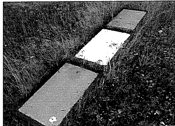
Fotografía N o 10 de 15/03/2012: Aeródromo La Junta. Baliza de hormigón de 60 cm por 100 cm.
