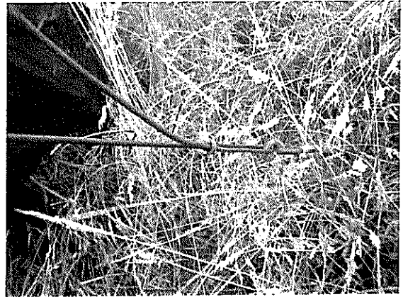
Fotografías N os 7 y 8 de 06/03/2012: Aeródromo de Quellón. Costado poniente. Pernos de sujeción y piolas con óxido.
