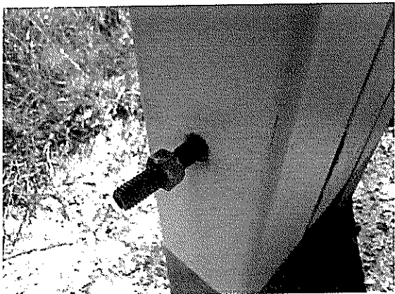
Fotografías N os 11 y 12 de 07/03/2012: Aeródromo de Tolquien. Costado poniente. Pernos de mástil oxidados y sueltos. Mástil con presencia de óxido.
