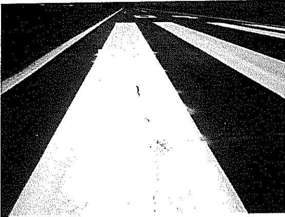
Fotografía N°91 de 29/03/2012: Villa Portales. Falta cubrimiento y uniformidad en señales de umbral de pista.
