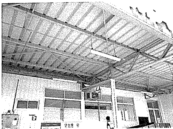
Fotografía N°15 de 26/03/2012: Aeródromo de Maquehue. Instalación de equipos fluorescentes de iluminación en el sector de plataforma de estacionamiento de aeronaves.
