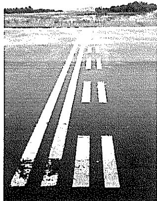
Fotografías N os 19 y 20 de 06/03/2012: Aeródromo de Quellón. Descascaramiento de pintura en señal designadora de espera de acceso a pista.
