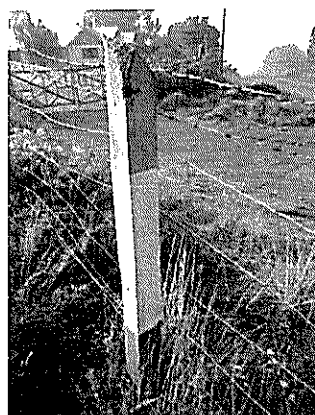
Fotografía N o 22 de 07/03/2012: Aeródromo de Tolquien. Falta de mantención de pintura y deterioro de postes en cerco de umbral sur.
